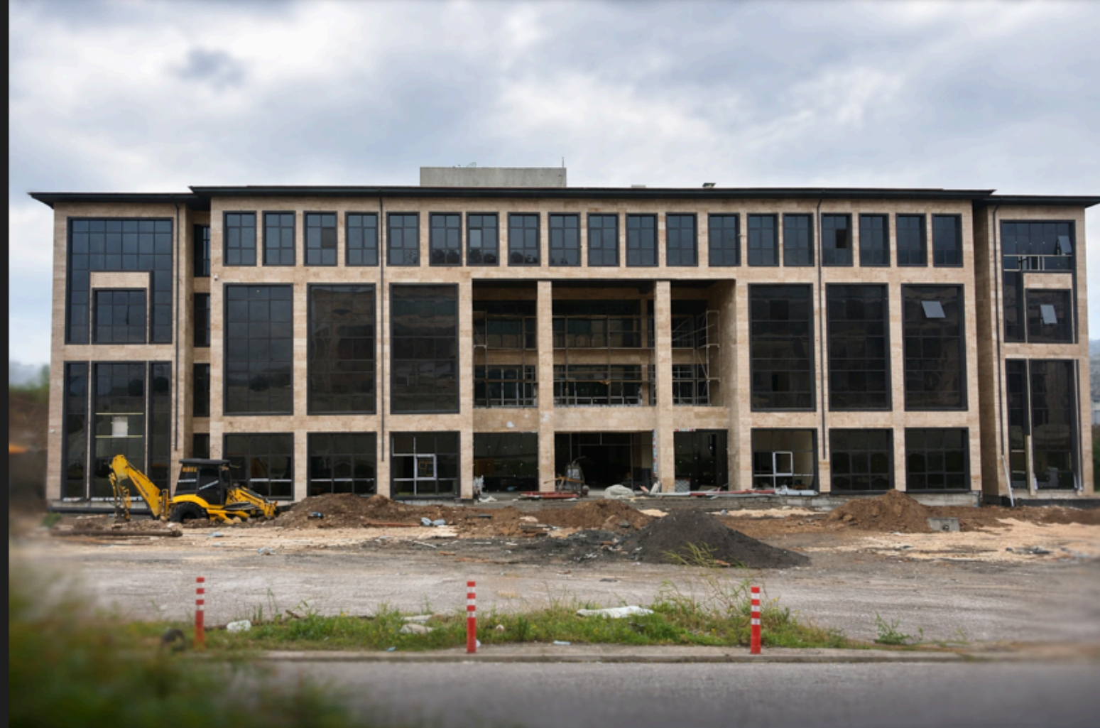
Samandağ Adalet Sarayı Projesi Demir Kapı ve Yangın Kapısı İşleri
