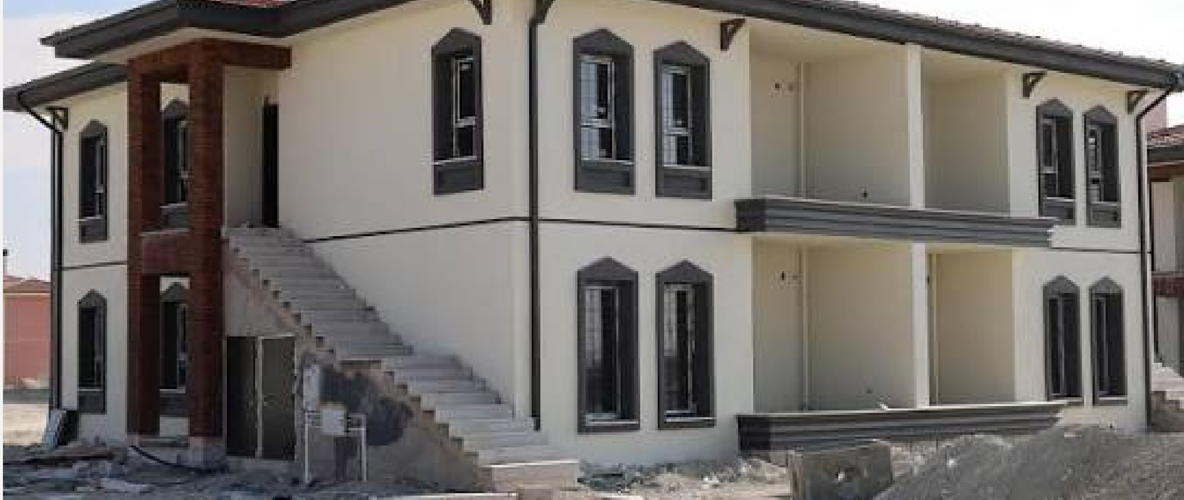
152 Konut TOKİ Projesi Çelik Kapı ve Demir Kapı İşleri
