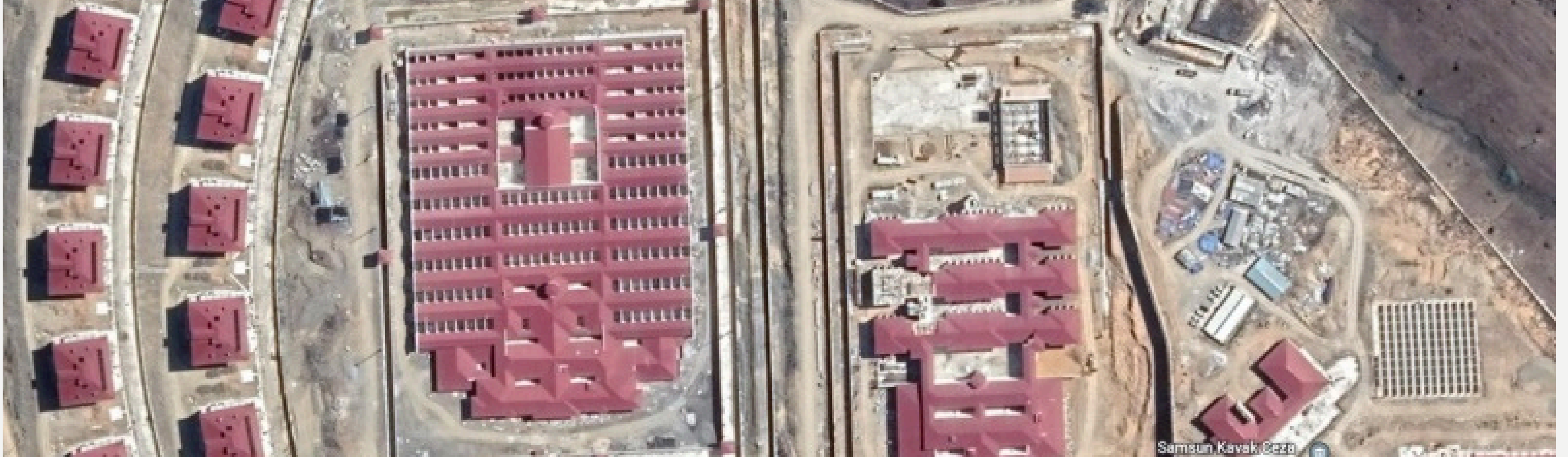
Cezaevi Kapı İşleri Projesi Demir Kapı ve Yangın Kapısı İşleri
