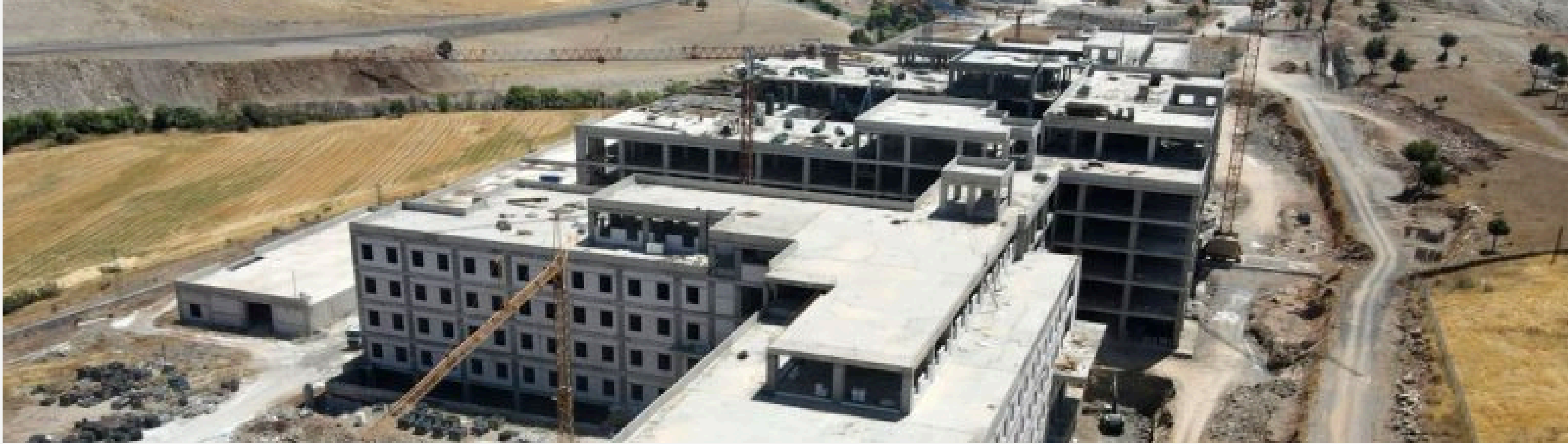
Şırnak Devlet Hastanesi Projesi Demir Kapı ve Yangın Kapısı İşleri
